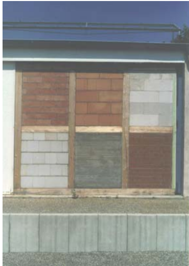
(a) Rohbau der Testwand
